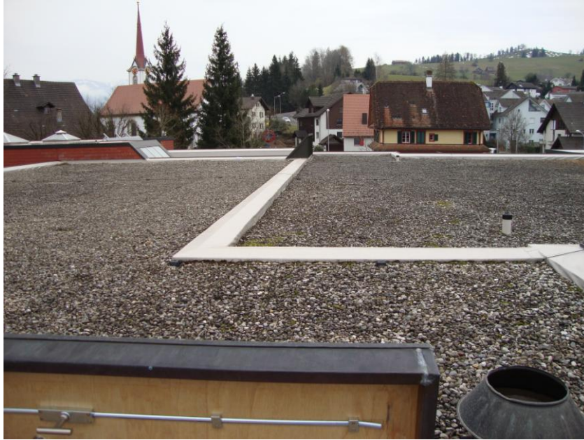
So sieht das Dach vor dem Beginn der Vorarbeiten aus.
