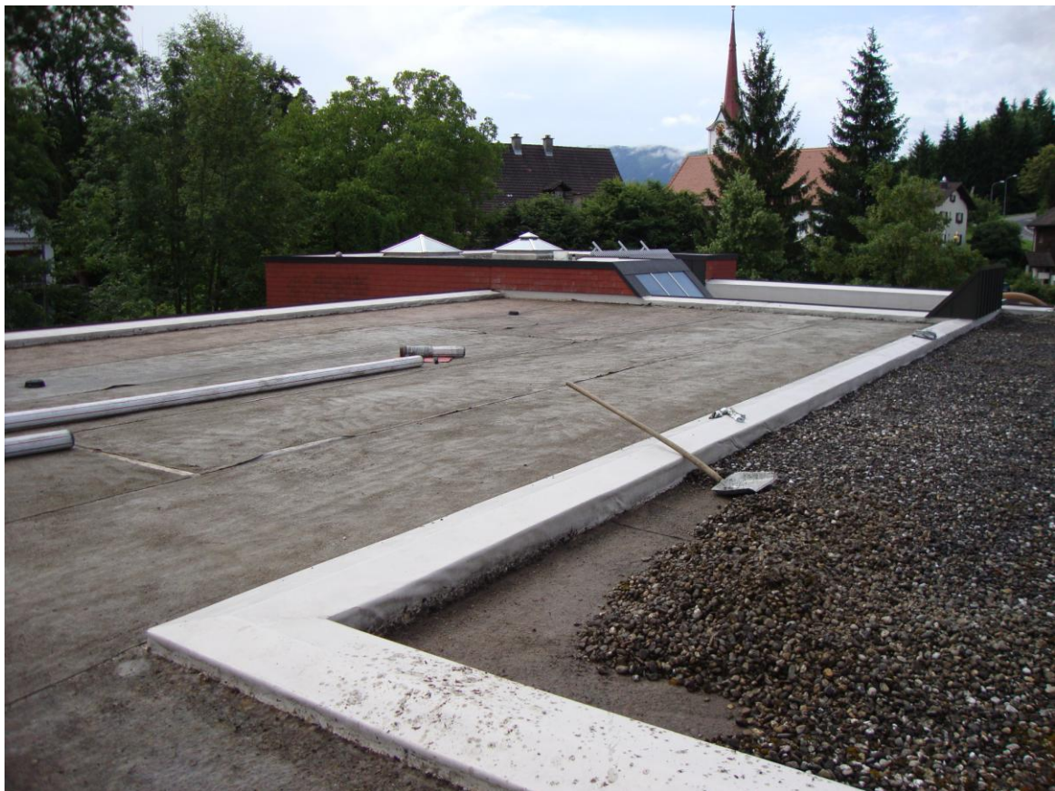
Das Dachkies wird abgesaugt und das alte Schutzflies wird sichtbar. Dieses Schutzflies wird anschliessend auch entfernt.
