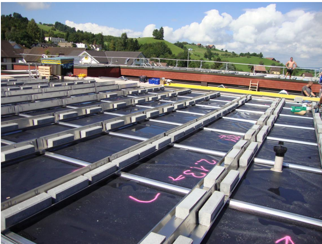
Die Unterkonstruktion wird gemäss Windkraftberechnung mit Gewichten beschwert.
